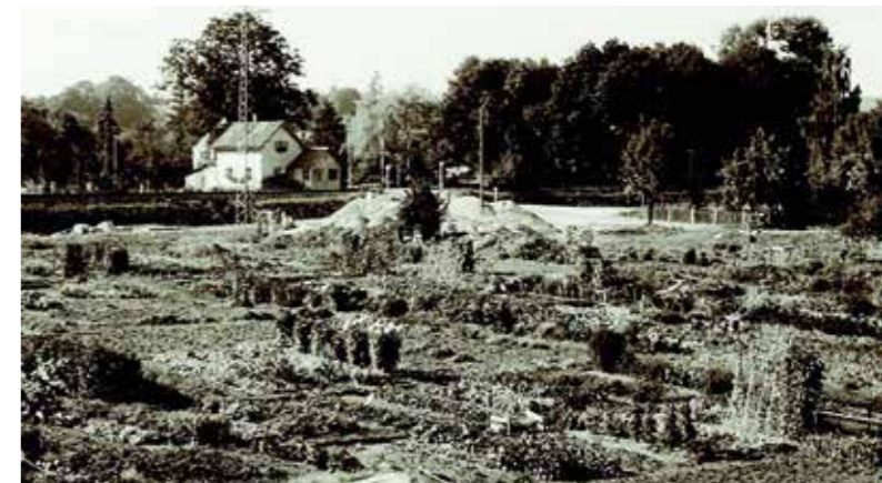
Der Bahnübergang Wotanstraße (Posten 9)
